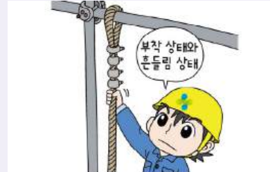
로프 부착 상태 및 매단 장치의 흔들림 상태
