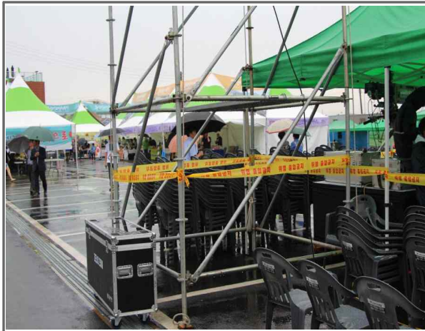
주무대 객석 뒤편 조명 트러스 주변에 설치된 안전 테이프
