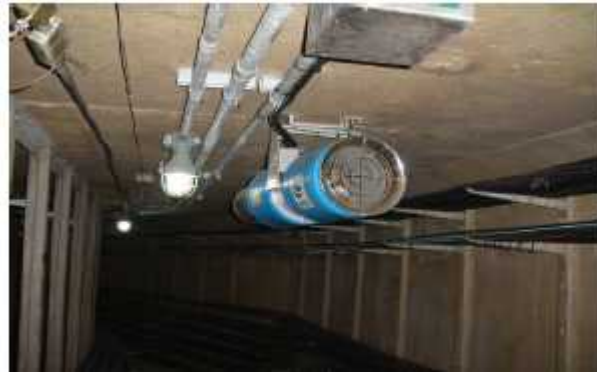
[그림5] 유인팬 설치[6]
