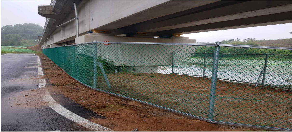
철도 주변에 설치된 철조망
